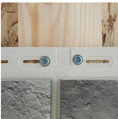
Саморезы в тело материала и край перфорации.
